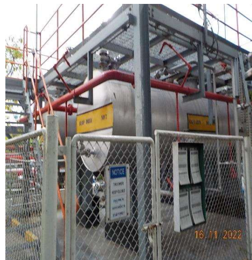
รูปที่ 2-3 Slop System สำหรับรองรับน้ำมันหกรั่วไหล
