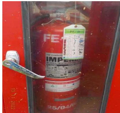
รูปที่ 2-25 การตรวจเช็คอุปกรณ์ดับเพลิงแบบมือถือ บริเวณหน้าท่าเทียบเรือ
