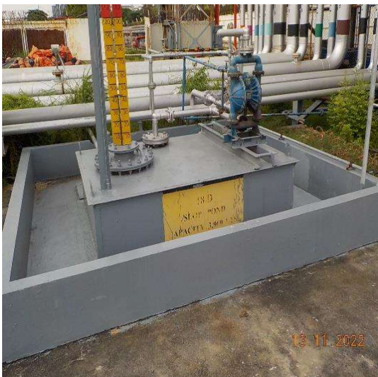
รูปที่ 2-3 Slop System สำหรับรองรับน้ำมันหกรั่วไหล
