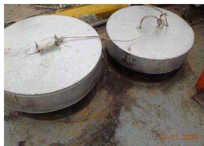
รูปที่ 2-11 ภาชนะรองรับน้ำมัน สำหรับรองรับบริเวณท่อรับ-จ่ายน้ำมัน
