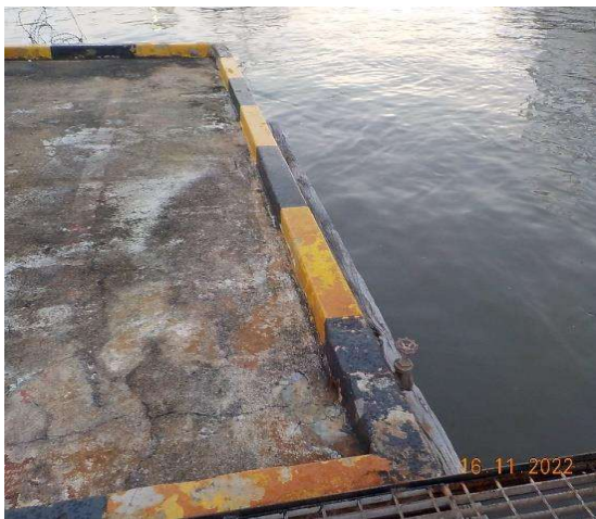
รูปที่ 2-2 ค้น Curb บริเวณขอบ Platform ของท่าเทียบเรือ
